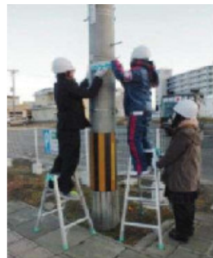
■水準器で示した高さに、津波痕の標識を設置する。
